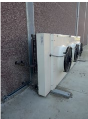
Afbeelding 27. Circulatiepomp (binnen) condensor (buiten)
