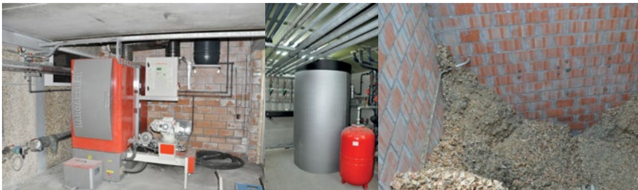
Afbeelding 13. Van links naar rechts: biomassa-installatie 80 kW, buffervat met een volume van 2000 l, voorraadbunker van \pm 30 \text{ m}^3
