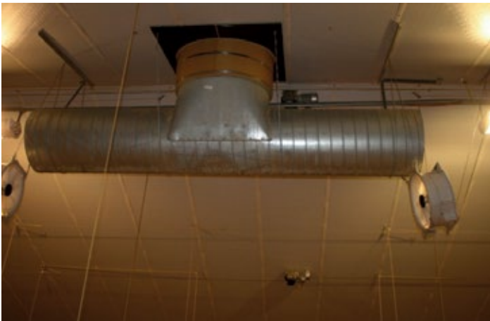
Afbeelding 20. Voorgeconditioneerde lucht komt via de nok in de stal
