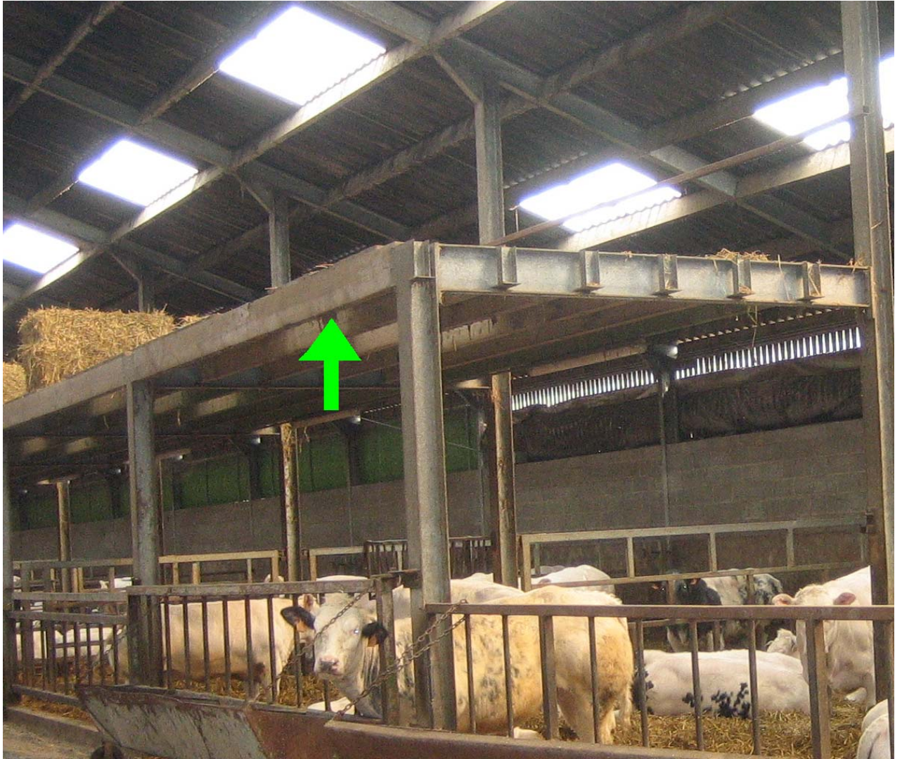
Figuur 65. Strozoldervloer die achteraan over gans de stallengte dicht is en vooraan op regelmatige afstanden uit openingen bestaat i.f.v. de ventilatie
