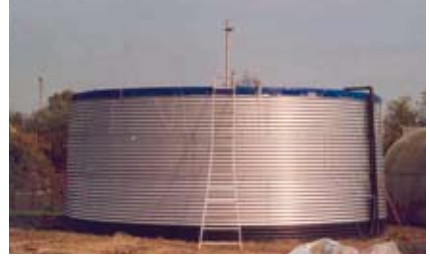
Hemelwateropvang in een metalen silo.
