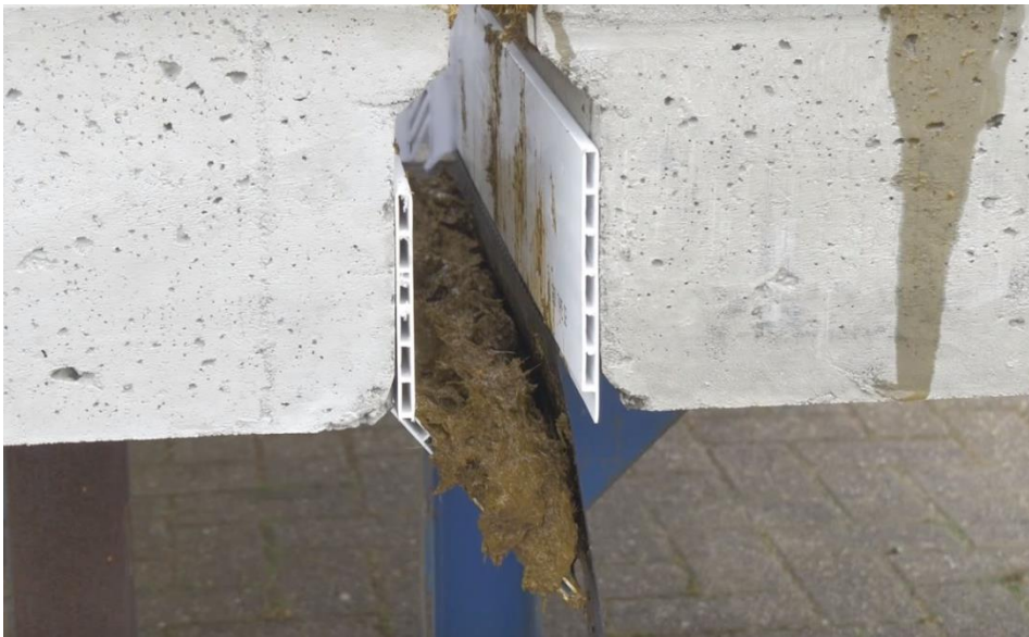
Figuur 21 Kleppensysteem voor PAS R-1.15 (Swaans Beton, sd)
