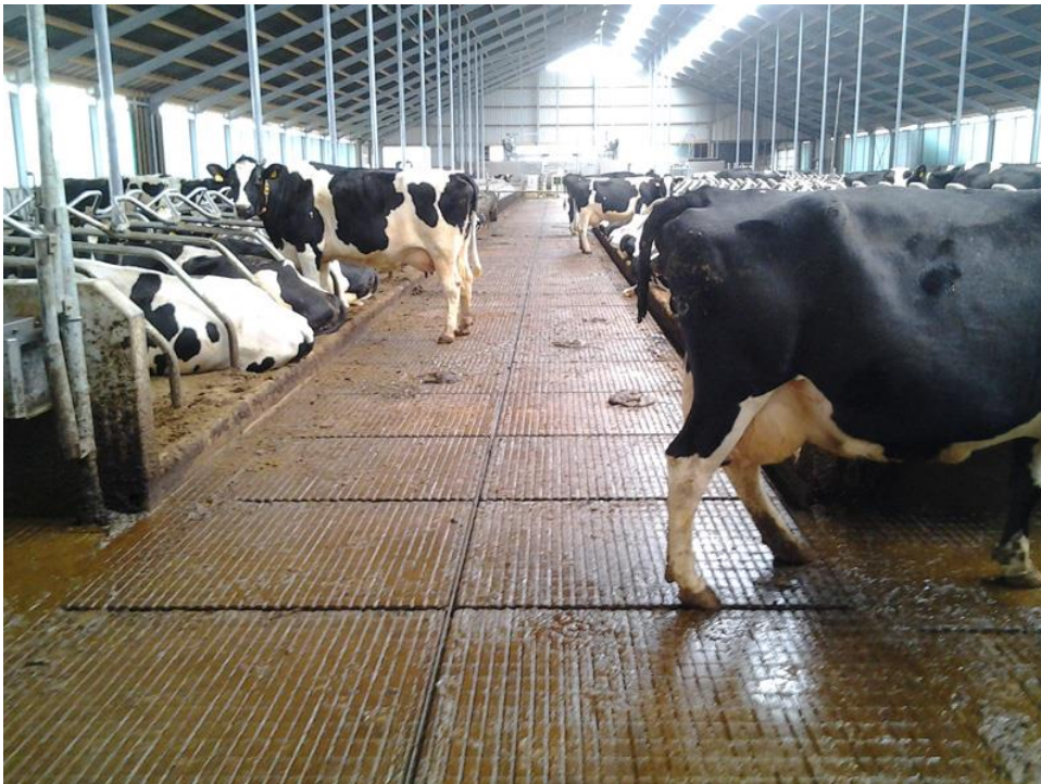
Figuur 17 Stal met HCI Welzijnsvloer 4 (HCI beton, 2013)
