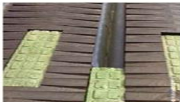
De roostervloer voorzien van rubbermatten en composietblokken met een hellend profiel, kunststofcassettes in de roosterspleten in combinatie met een mestschuif en mestrobot levert 41% reductie op.
