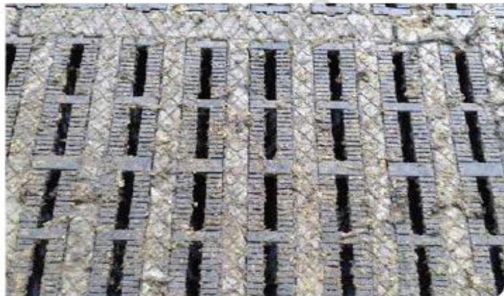
De Eco-vloer is een geprofileerde vloer met rubberen inserts.
