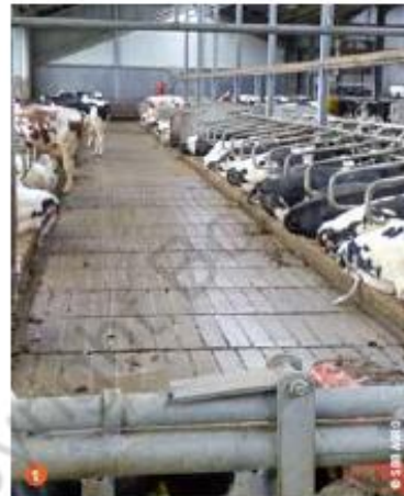
1 De Swaans G2.2-vloer ligt vlak, maar de profilering helt af. 2 Bij de Swaans G6 is een goede mengsmering nodig om de vloer proper te houden.
