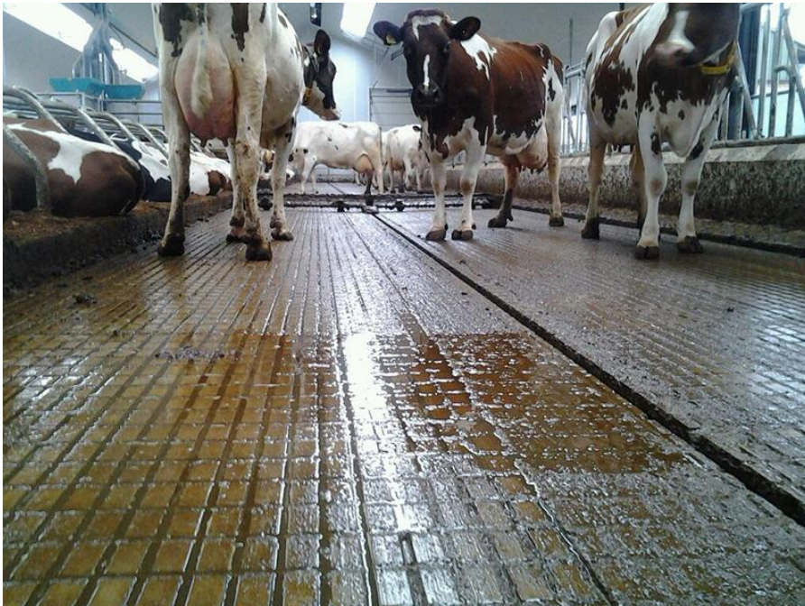
Figuur 19 HCI welzijnsvloer 5 (HCI beton, sd)
